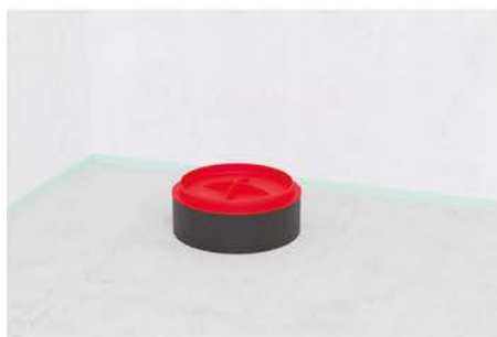
7. Vybetonovat podlahu do roviny
