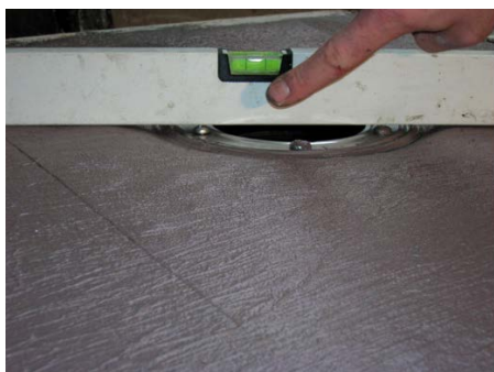
10. Bezproblémová pokládka dlažby je možná: celá izolační souprava leží pod úrovní betonové mazaniny
