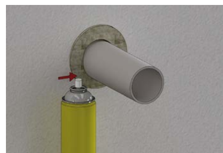
12. Volný prostor mezi odtokovou trubkou a ostěním otvoru vyplnit PU pěnou
