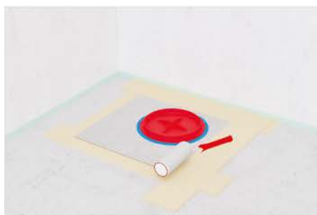
10. V celé ploše sprchového koutu provést hydroizolační těsnicí nátěr - těsnicí manžetu řádně zapracovat do vodotěsné izolace (sendvič) včetně řešení detailů s těsnicími páskami atd...
