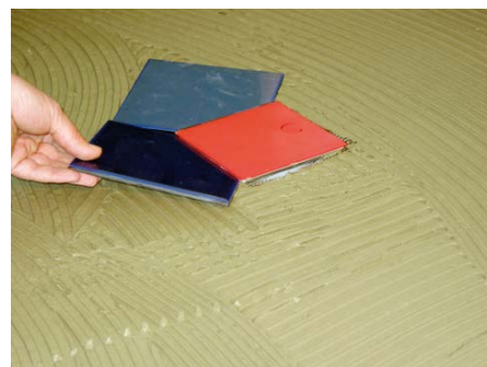
12. Vložit nástavec bez těsnícího kroužku, položit dlažbu
