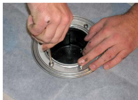
5. Nerezovou svěrnou přírubu přitáhnout k izolační přírubě vtoku pomocí šroubů z balení
