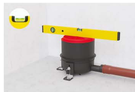
6. Vytvořit spád potrubí, napojit těleso odtoku na odpadní potrubí a vyrovnat pomocí fixačních úhelníků
