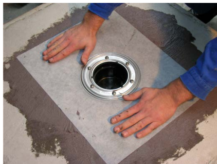
8. Izolační folii vyhladit do vlhkého podkladu
