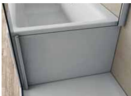
■ Detail napojení zkrácené boční stěny k vaně.
